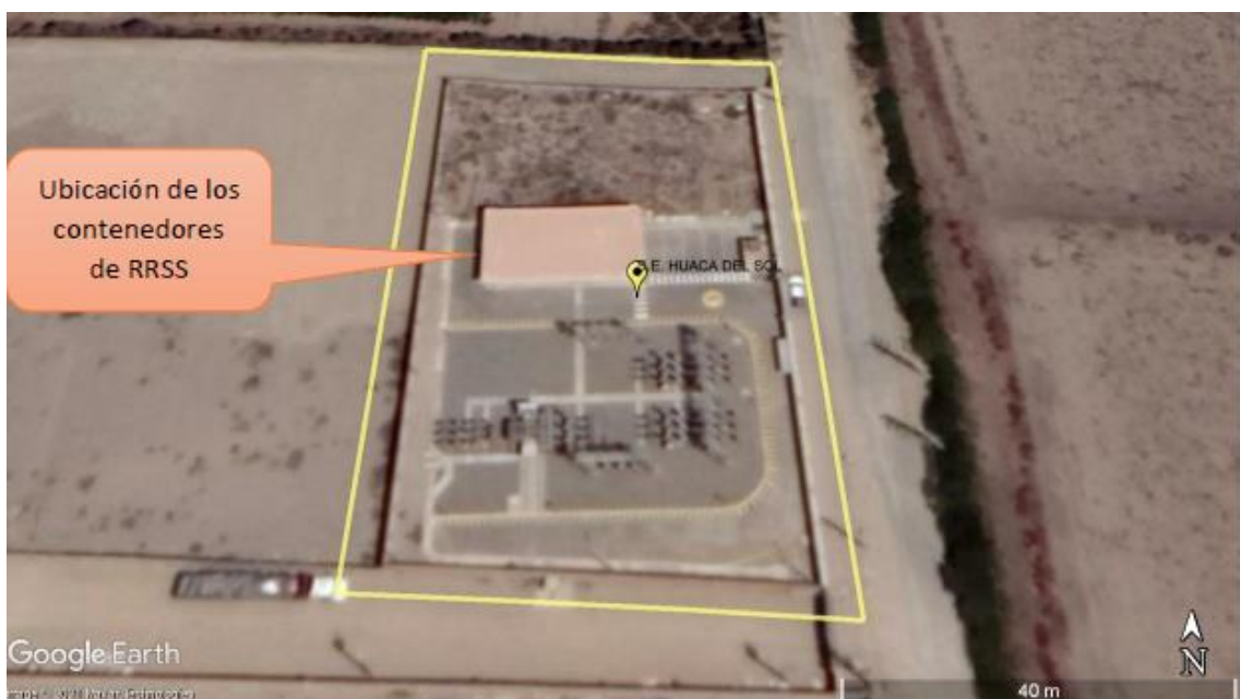
Figura 3. Ubicación del almacenamiento de RRSS
